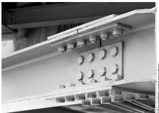
Ligação por parafusos em estrutura metálica.
